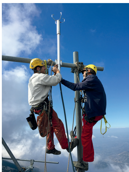
Figure 3. Installation de l'anémomètre au mont Ventoux.
